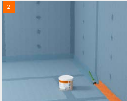
2 fermacell™ vloeibare folie in de hoeken aanbrengen
