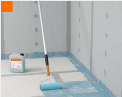
1 fermacell™ diepgrond op de daarvoor aangewezen zones met een rol aanbrengen
