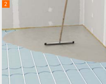
2 Over de Therm25™ elementen fermacell™ gipslijm uitgieten.
