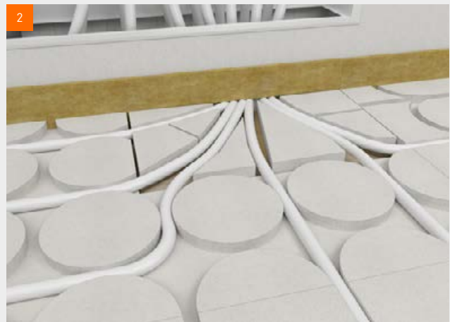
Opvullen met stukken uit fermacell® Therm 25™ of bijvoorbeeld honinggraatkorrels.
