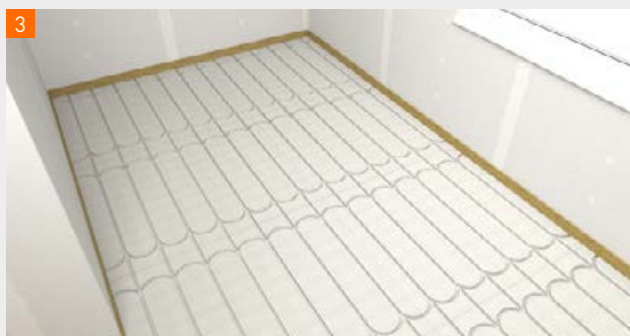
De ruimte dichtleggen met fermacell® Therm25™ elementen.
