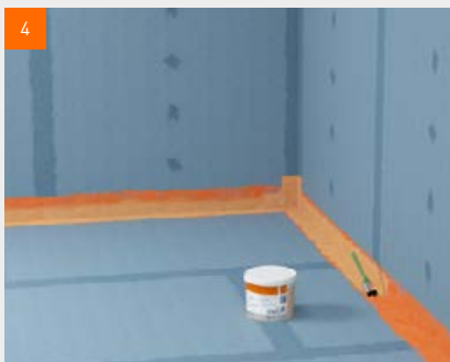
4 De afdichtband direct nadat hij in de folie gedrukt is, met fermacell™ vloeibare folie overschilderen
