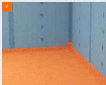
5 De vlakken in W1-l-zones volvlaks aanbrengen
