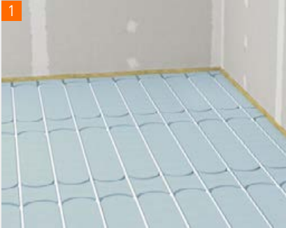
1 De aangebrachte vloerverwarmingsleidingen van 16 mm.
