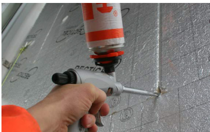
Eventuele openingen en kieren afdichten met elastisch PUR schuim.
