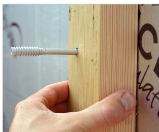
Regels vrij laten hangen op de gevelschroeven.
