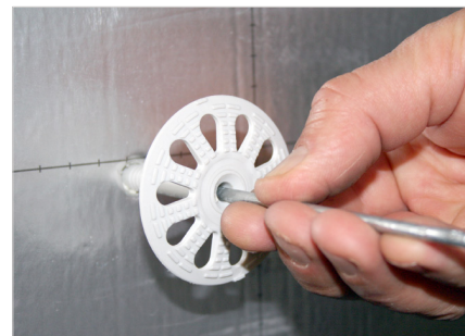
Spouwisolatieplug als geheel zonder gereedschap in het boorgat plaatsen.
