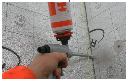
Eventuele openingen en kieren afdichten met elastisch PUR schuim.
