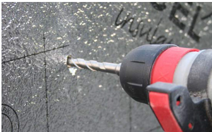
Basisplaat op het binnenspuwblad bevestigen met een Porofast isolatieplug SS. Deze duurzame mechanische bevestiging zorgt voor een perfecte aansluiting op de draagmuur.
