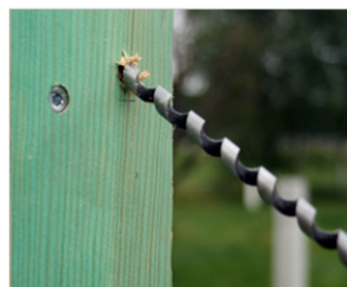
Volgens voorschriften voldoende gevelschroeven onder 30° bijplaatsen.
