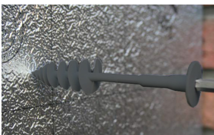
Tweede isolatielaag wordt met de Porofast isolatieschroef verspringend bevestigd op de eerste laag.
