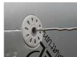
Indien nodig ombuigen van het spouwanker volgens buitenmuur (zie hierboven).
