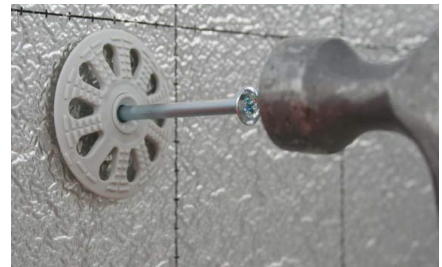
Basisplaat op het binnenspuwblad bevestigen met een Porofast isolatieplug SS. Deze duurzame mechanische bevestiging zorgt voor een perfecte aansluiting op de draagmuur.
