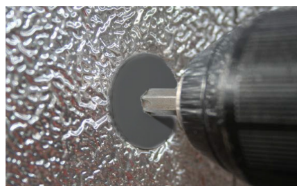
Tweede isolatielaag wordt met de Porofast isolatieschroef verspringend bevestigd op de eerste laag.
