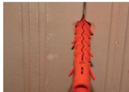
Positioneer de plug correct voor een horizontale expansie in de stootvoeg.
