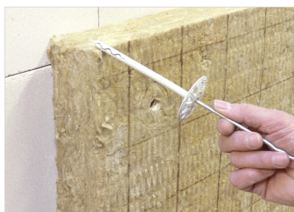
De plug wordt tot aan de weerstand op het spouwanker geklikt tot één geheel.
