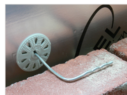
Eventueel ombuigen van het spouwanker.
