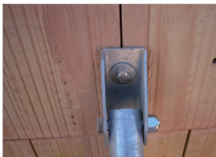
Draai de bout inclusief 3D sluitring in de plug, indien machinaal op laag toerental.
