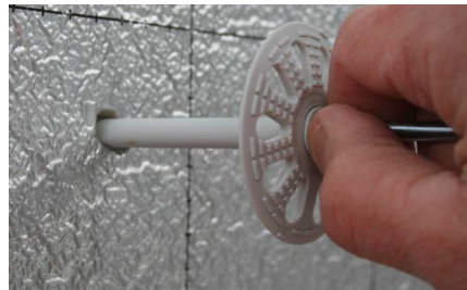
Basisplaat op het binnenspuwblad bevestigen met een Porofast isolatieplug SS. Deze duurzame mechanische bevestiging zorgt voor een perfecte aansluiting op de draagmuur.
