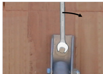
Haal de bout ter controle manueel aan, vast = vast!
