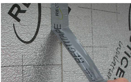
Indien gewenst naden afdichten met isolatietape.
