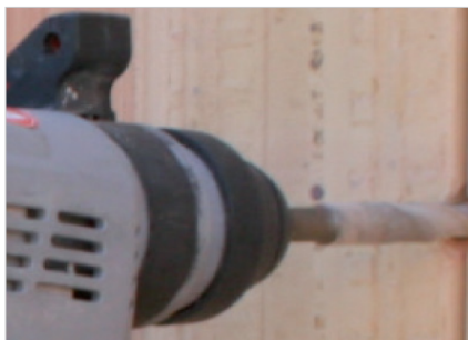
Boren in de stootvoeg.
