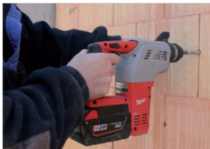
Boren met diameter 13 mm (+ 2/3 van het muurelement).
