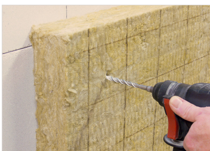
Plaats de spouwisolatie en boor een gat van 8mm door de isolatie.
