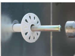
Sla de plug volledig in met behulp van het inslagpijpje
