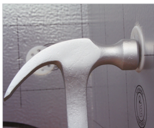
Bevestig het isolatiemateriaal met isolatiedoorns.
