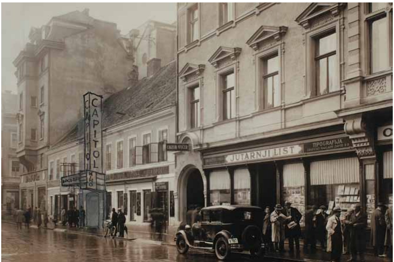
Kuća Granitz poslije 1926. Do nje stara kuća s kavanom „Metropol“; pri kraju kuća Ernesta Ehricha (Varšavska 2-2a), sagrađena 1923-24. prema projektu Huga Ehricha.
