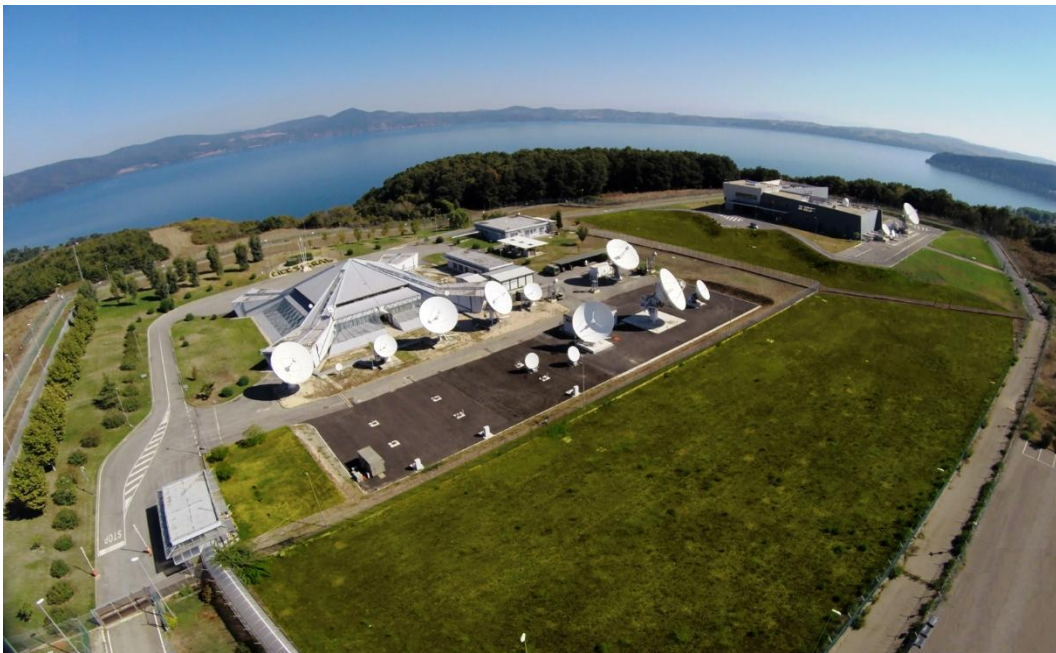
Figura 28 - Il centro di controllo del sistema di telecomunicazioni italiano Sicral (Fonte Telespazio 68 ).
