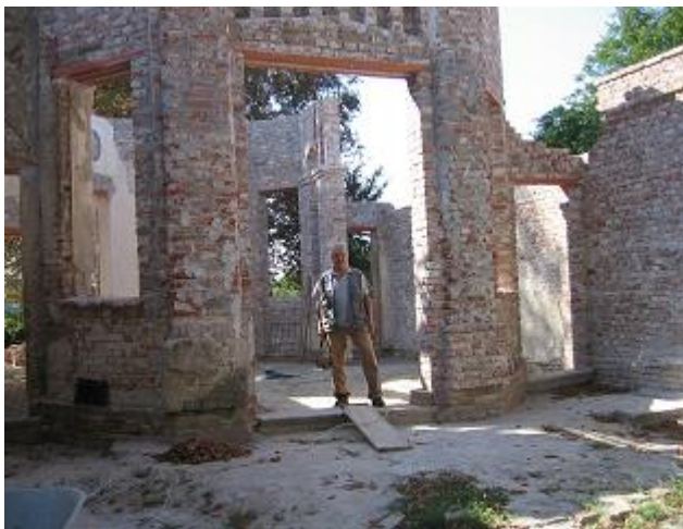
Vukovar, obnova kapelice na groblju
